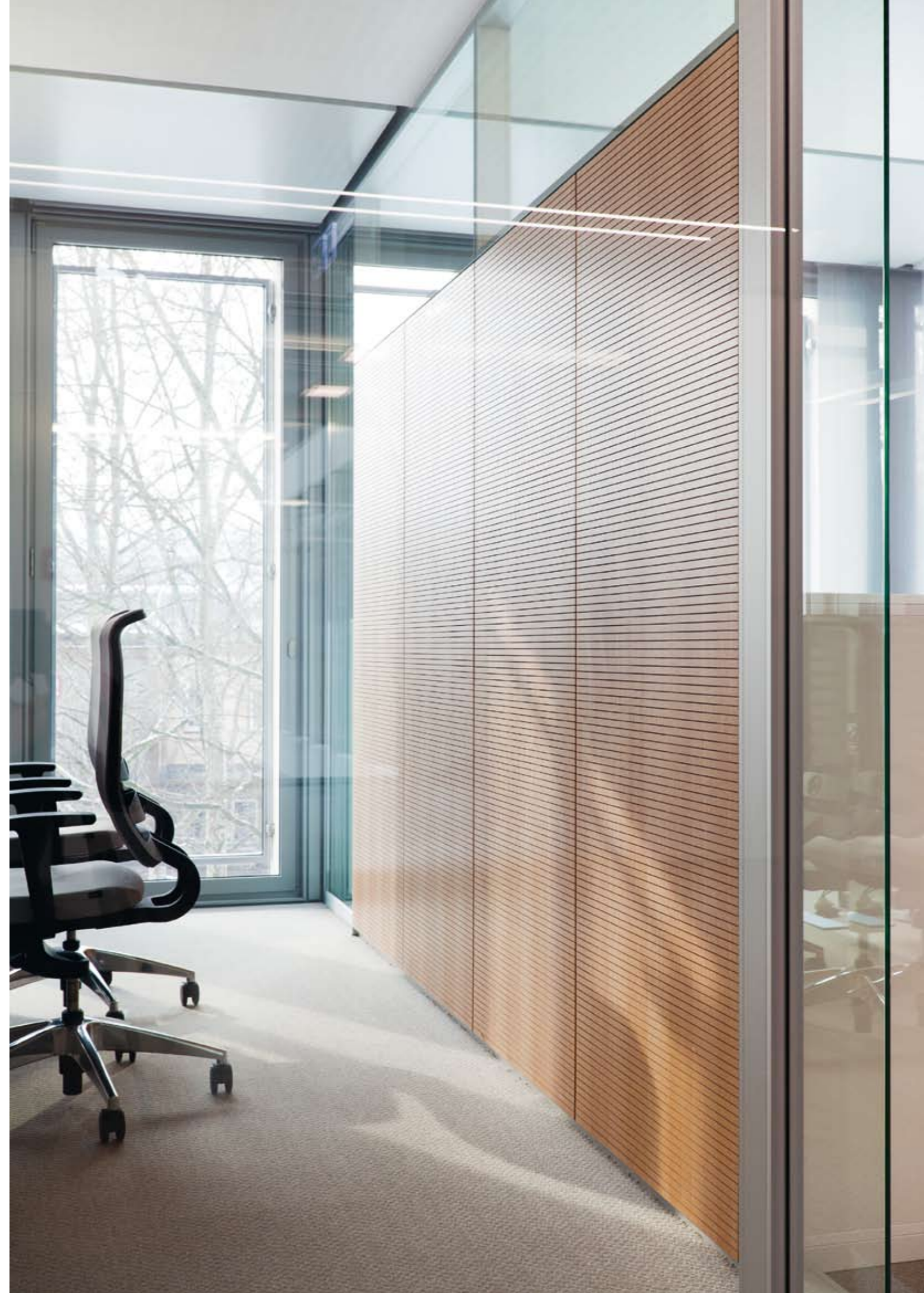
Akustik: fecophon mit Schlitzung 14/2 Oberfläche: Furnier Eiche natur Ausbauraster: B x H = 0,80/1,60 x 2,80 m Projekt: Kreissparkasse Göppingen Planung: Auer+Weber+Assoziierte GmbH, Stuttgart
